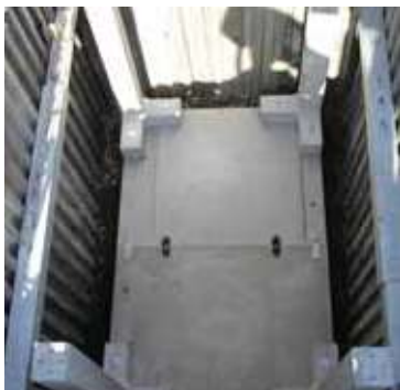
製品据付完了
