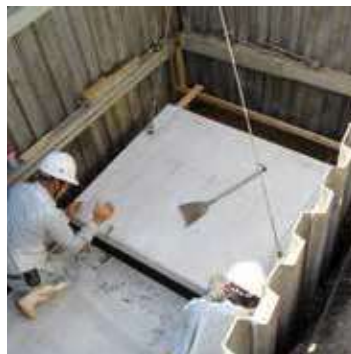
基礎スラブ据付
