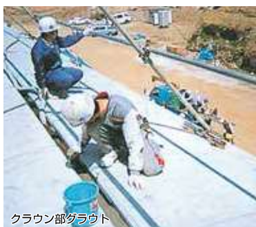
クラウン部グラウト
