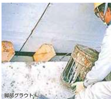
脚部グラウト
