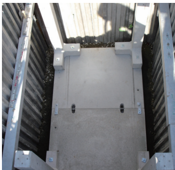
製品据付完了
