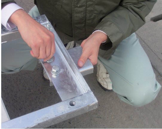
1. 差込金具を受枠に片側だけボルトで仮締めをします。
