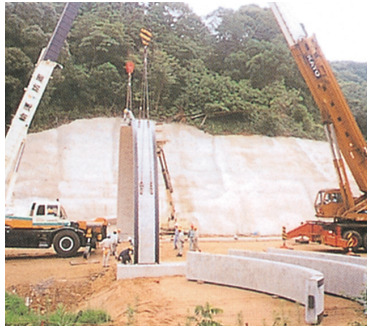
■仮設した部材を反転させ、左右交互に組み立て、架設します。
