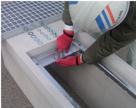
3. 反対側の差込金具を固定します。
