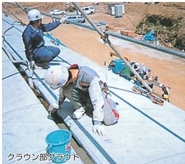
■ヒンジ部分に当たるクラウン部、脚部にグラウトを行います。
