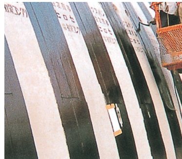
■目地部に防水シートをはり、水の浸入を防ぎます。
