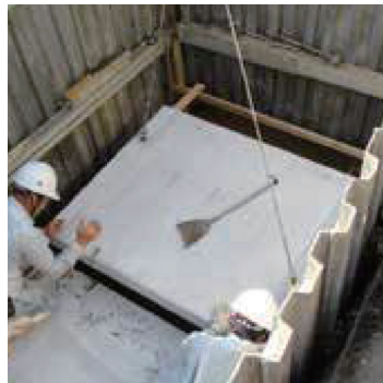
基礎スラブ据付
