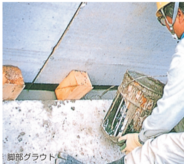
■ヒンジ部分に当たるクラウン部、脚部にグラウトを行います。
