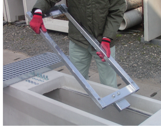
2. 側溝本体に受枠をセットします。
