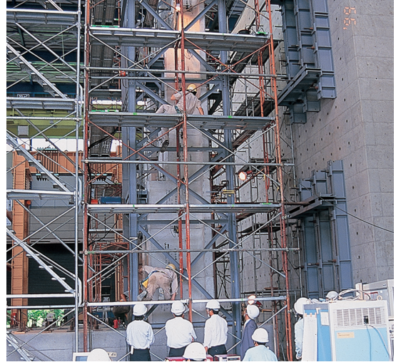
■構造耐力実験の実施状況
