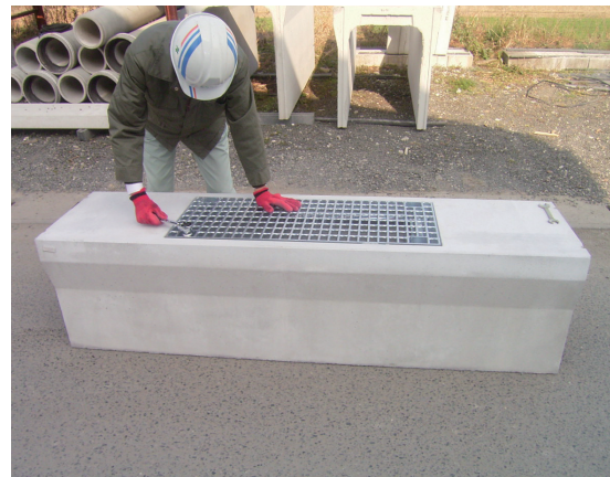
6. ボルト締めを行い、施工完了。
