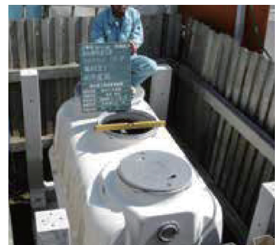
浄化槽レベル確認
